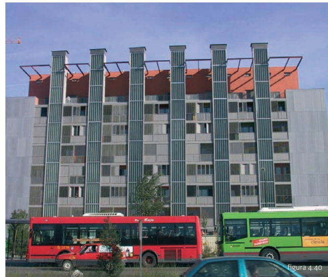
Fig. 4.37 - 4.40. Edificio de viviendas EMV. Chimeneas de extracción. Madrid. AUIA. 2003
