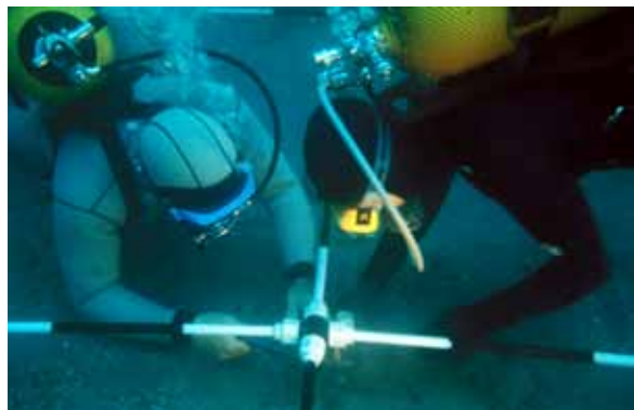
Fig. 53: Detalle de la junta cruzada para la conexión de los tubos en plástico
