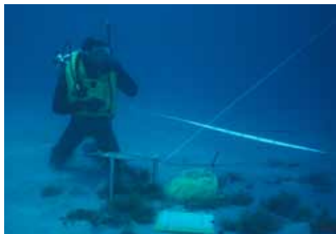
Fig. 50: Operación de alineación de los ejes con compás
