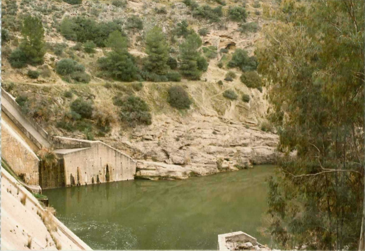
DR-9211.- Estribo sur de la Presa de Cordobilla, arma sobre los conglomerados facies fan-delta del Mioceno Superior terminal (14).
