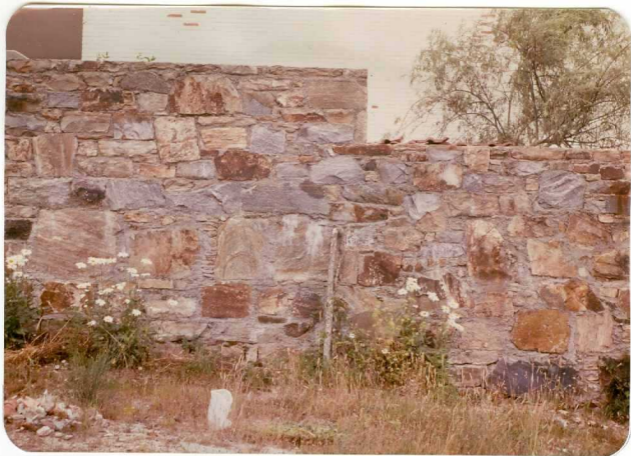
05-09/GP/EK-491.- Uso de bloques rectangulares de ortogneis (oꝝ) como material de construcción. Gru p o escolar de Forcarey.
