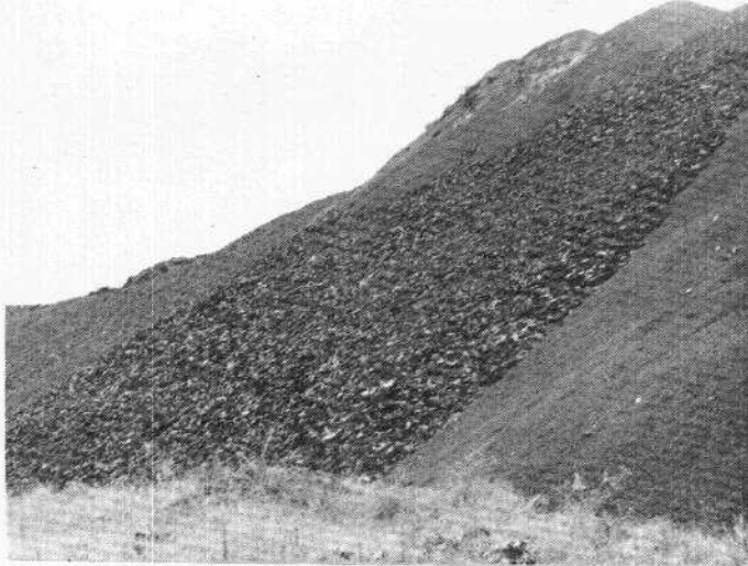
Foto 2.— Talud de la escombrera del lavadero de carbón de la empresa ENCARSUR en Peñarroya. Es de notar los tamaños diferentes vertidos.
