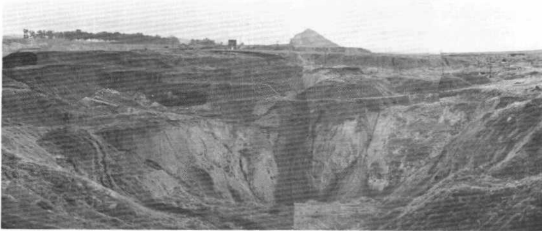
Foto 1.— Conjunto de escombreras de estériles y mixtos de carbón de edad avanzada en Peñarroya. Los taludes y formas han sido suavizados por la meteorización. Al fondo silueta del Ceno Antolín. En primer plano embudo formado al extraer materiales para ser relavados en el lavadero de la empresa M a Rodríguez de Velasco.
