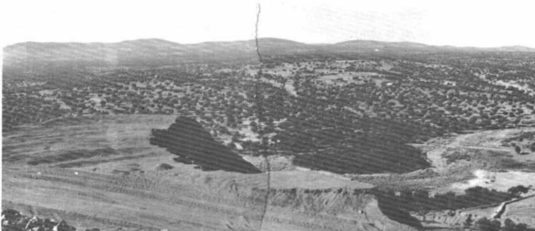
Foto 9.— Escombrera de la mina de plomo Las Morras del Cuzna en Villanueva del Duque (Córdoba). Se observa homogeneidad de tamaños. En la esquina inferior izquierda aparece un retazo de otra escombrera hecha con materiales gruesos y desde la que está tomada la fotografía.
