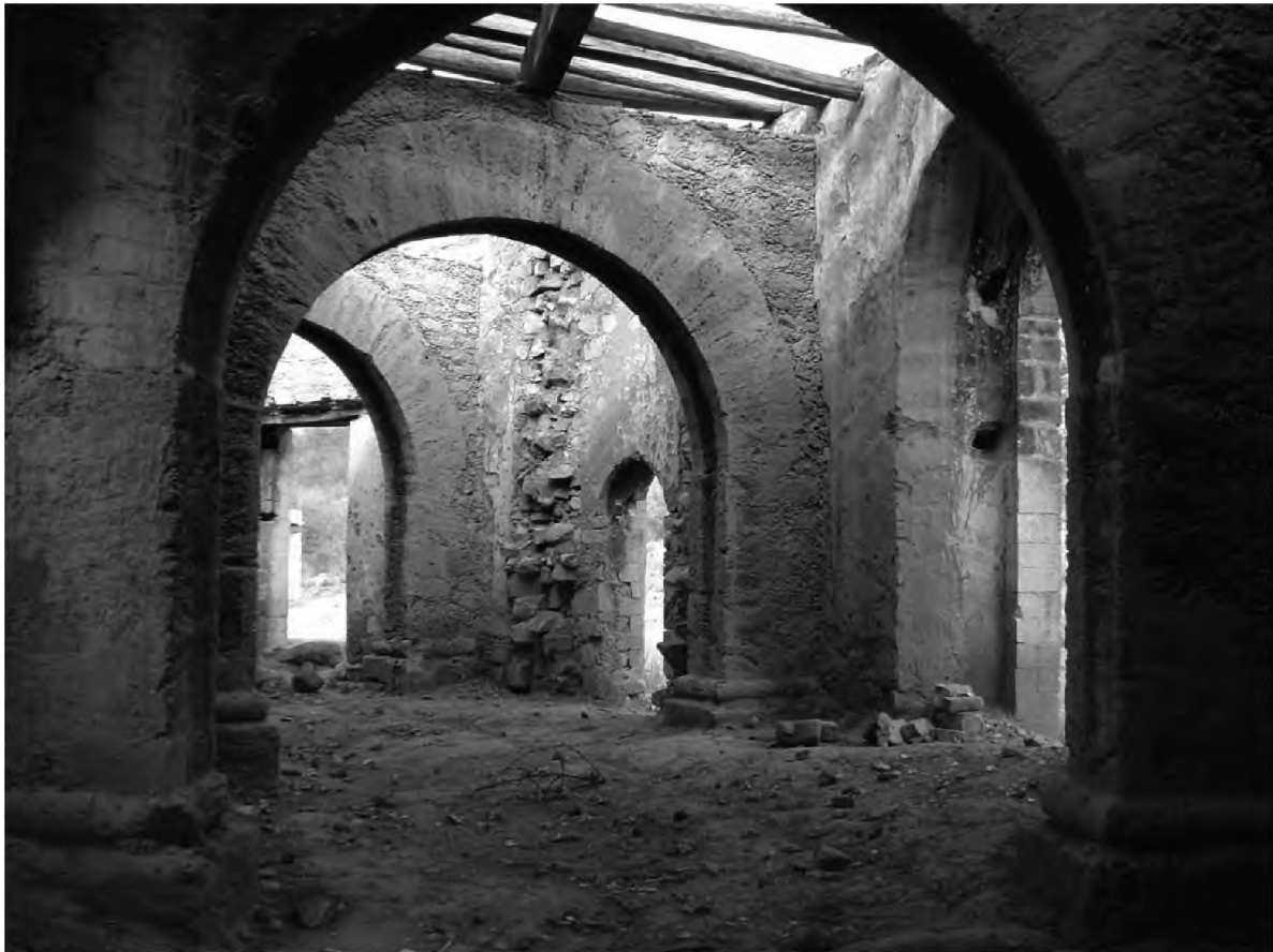
Fig. 5. Vista interior del andén. Fotografía del autor (2011)
