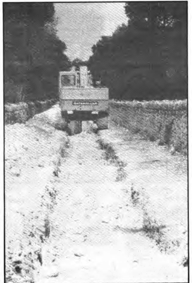
Les obres dels transvasament de les aigües de Sa Marineta són il·legals. Els Ajuntaments de Llubí i d'Inca no han rebut cap notificació i les obres han començat sense permís. Està ben clar que els qui comanden es comporten com lladres, arriben de matinada i sense avisar.
