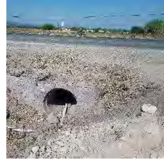
Ilustración 35. Obra de drenaje se observa sin obstrucciones, hasta el momento no se han colocado los tramos de tubería por donde cruzará la ciclovia.
