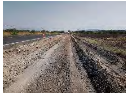
Ilustración 45. Material de arripe colocado a un costado de las obras de subrasante de la ciclovia.
