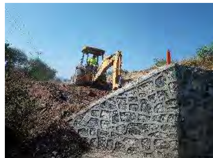
Ilustración 37. Acondicionamiento del margen del puente, con respecto a la colocación del material de subrasante; retiro y despalme de material.
