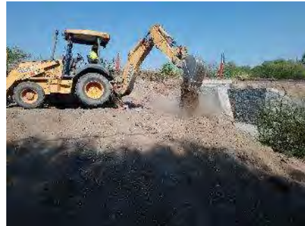
Ilustración 45. Acondicionamiento de obras de drenaje en las actividades de construcción de la ciclovia
