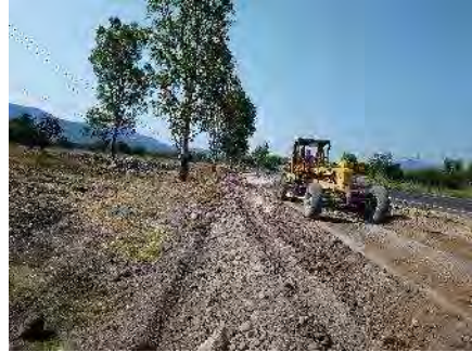
Ilustración 17. Maquinaria que operó en las obras de construcción de la segunda etapa se encontró en buenas condiciones de funcionamiento.
