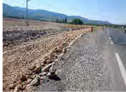
Ilustración 44. Avance de obra; colocación de material de compactación para subrasante; vista panorámica del sitio de obra.
