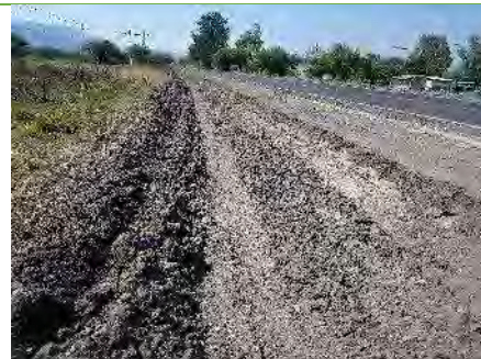
Ilustración 38. Despalme realizado exclusivamente con maquinaria.
