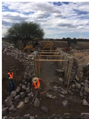
MAMPOSTERIA EN ALEROS EN OBRAS DE DRENAJE 2+680, 2+845 Y 3+062 ADEMAS MURO Y ZAPATA DE LA OBRA 3+650
