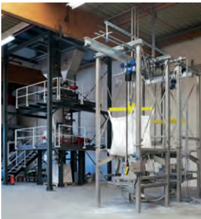
Estación de descarga de Big Bag para la extracción y transporte de diferentes tipos de polvo, en parte materiales sólidos abrasivos en un dispositivo mezclador.
