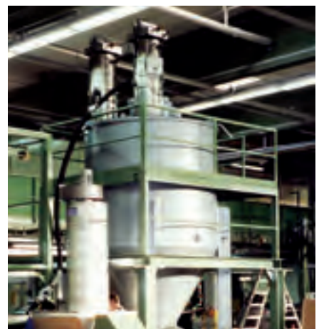
Alimentación continua de depósitos de mezcla y de reacción para la producción de adhesivos.
