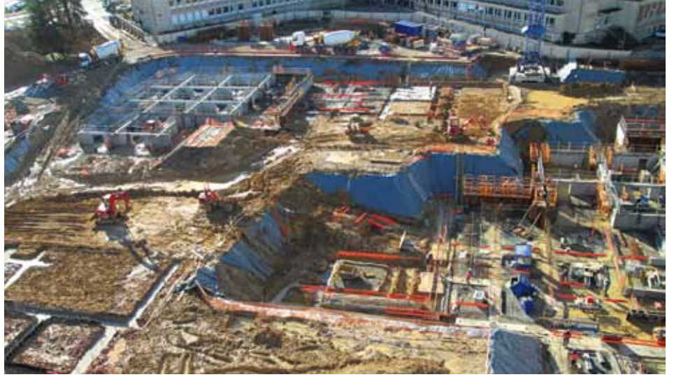
Sogea CHU Poitiers bâtiment NCV
