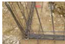
Nœud de chaînage Continuité mécanique
