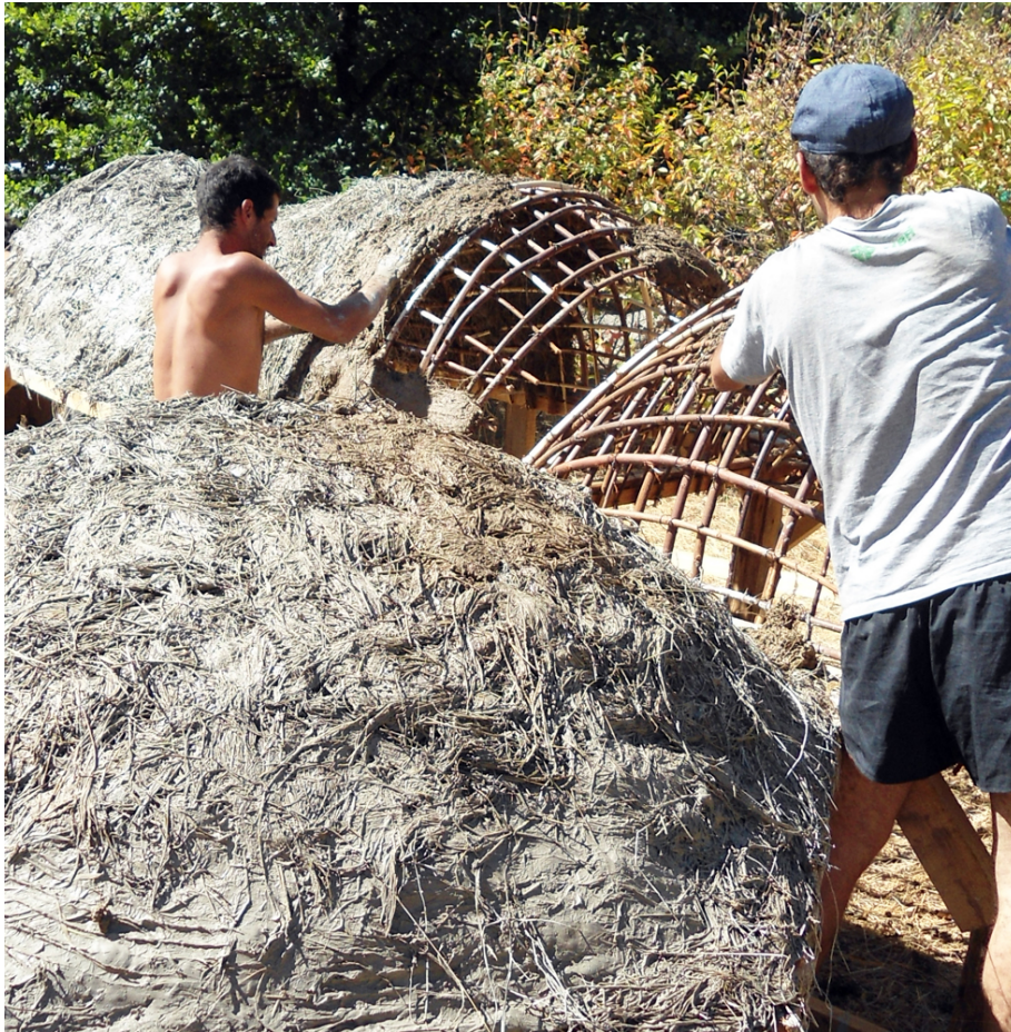
Imagen 7. Construcción de las superficies curvas de revolución y traslación. Se puede verificar la trama de la estructura/esqueleto y el primer cubrimiento de fibra y arcilla.
