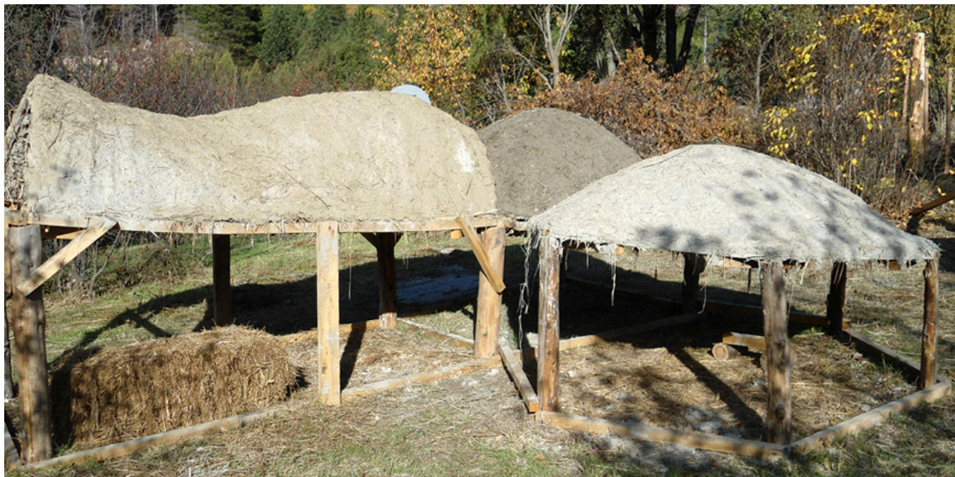
Imagen 9. Superficies curvas de revolución y traslación con la primera cubierta de fibra y arcilla.
