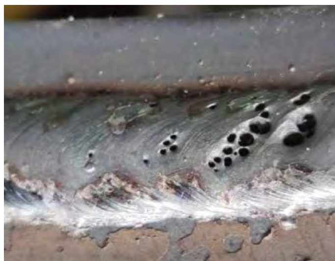
Figura 1. Poros en una soldadura de acero con el proceso 138.
