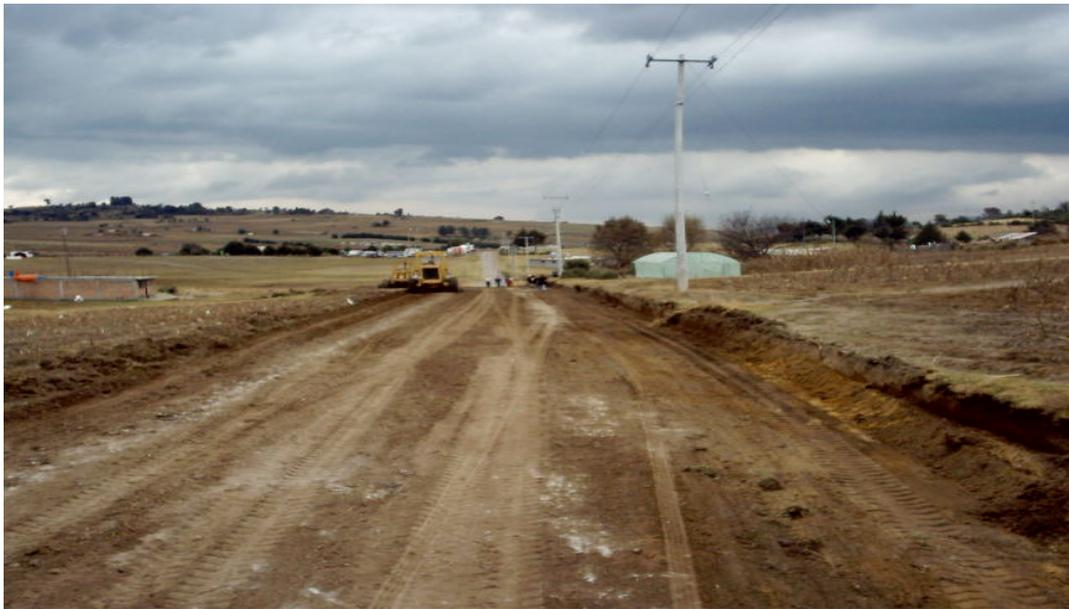
Figura 6.2 Motoconformadora Homogeneizando el Material.
