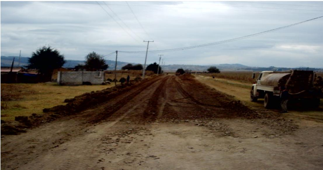
Figura 6.1 Incorporación de Agua con la Pipa.
