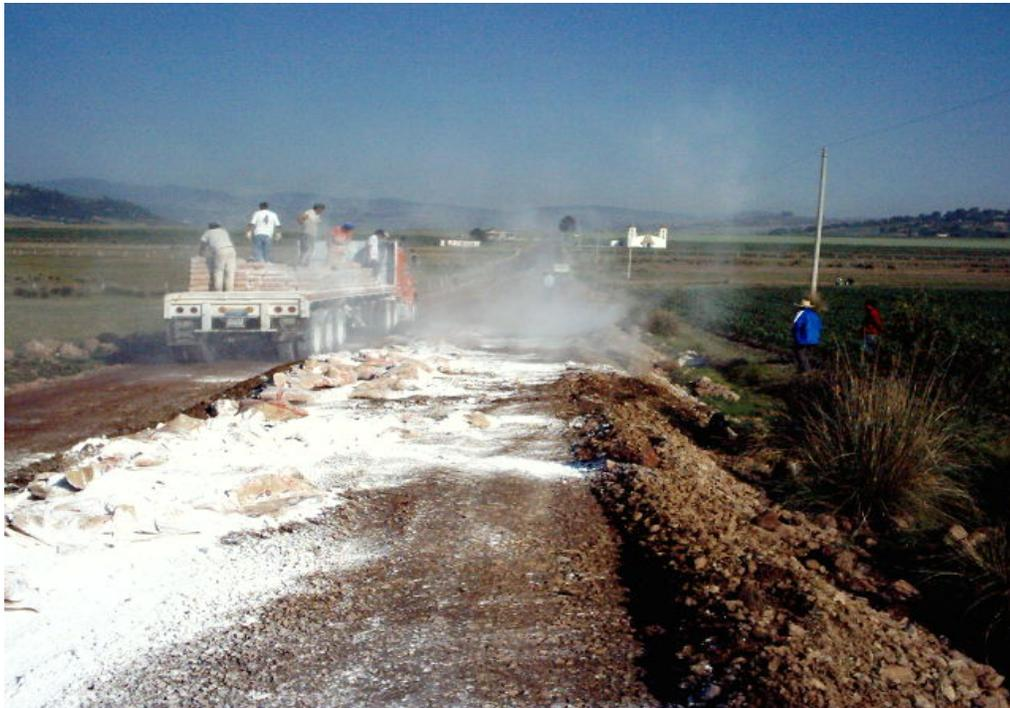
Figura 6.4 Material Estabilizado con Cal Hidratada.
