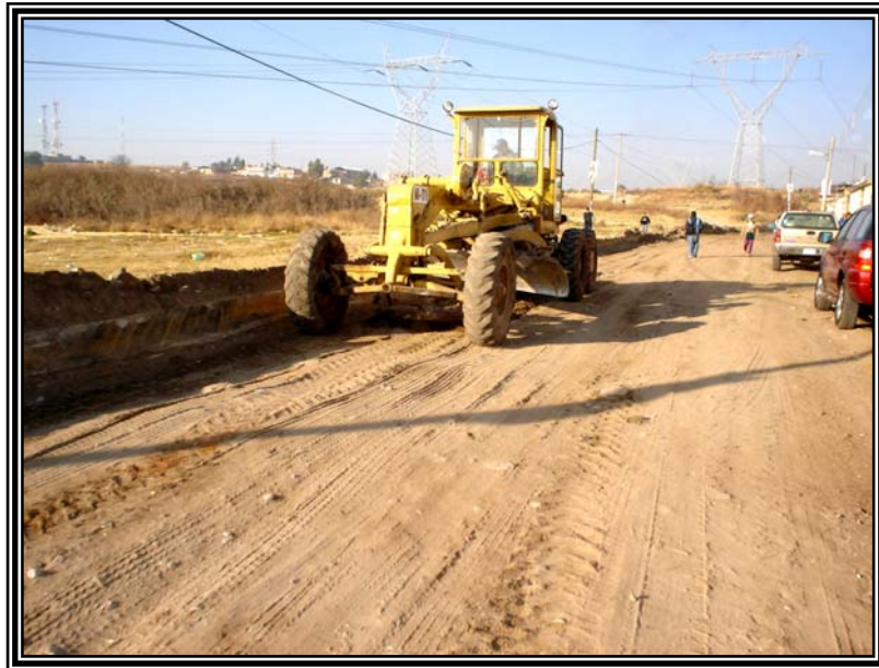
Figura 23. Formación y compactación de capa subrasante.
