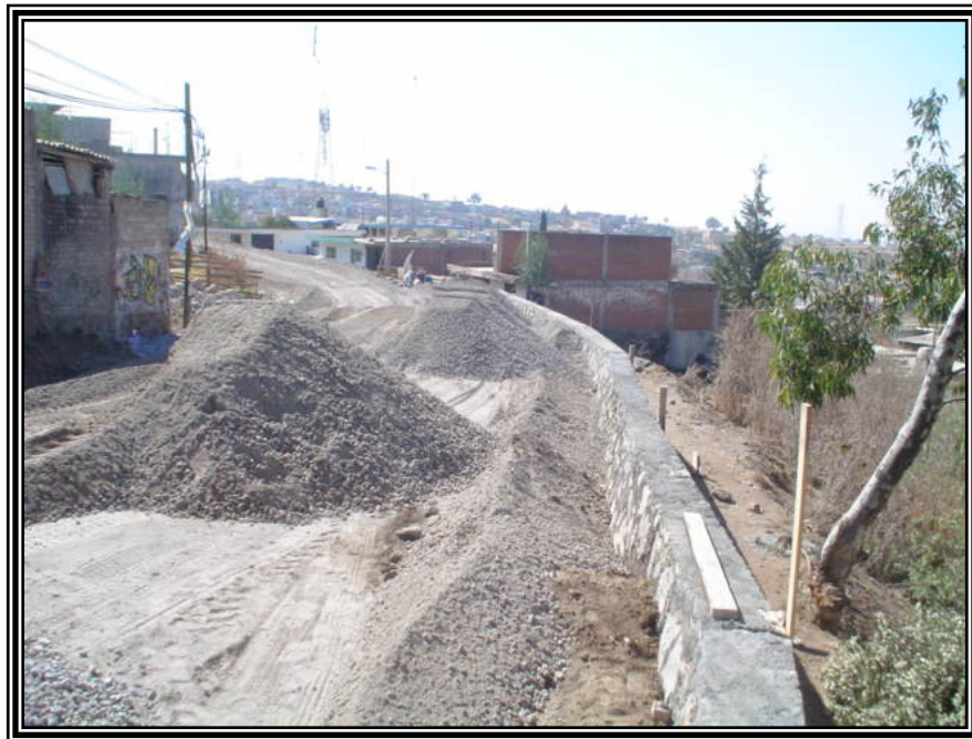
Figura 25. Material utilizado para la formación de la base hidráulica.
