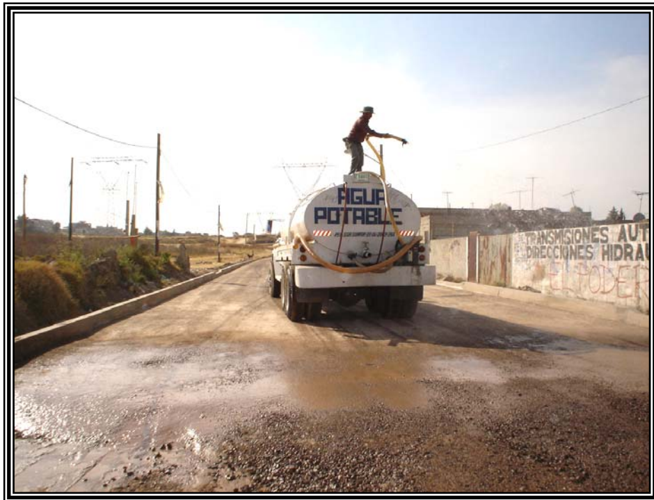
Figura 24. Riego sobre la capa subrasante.
