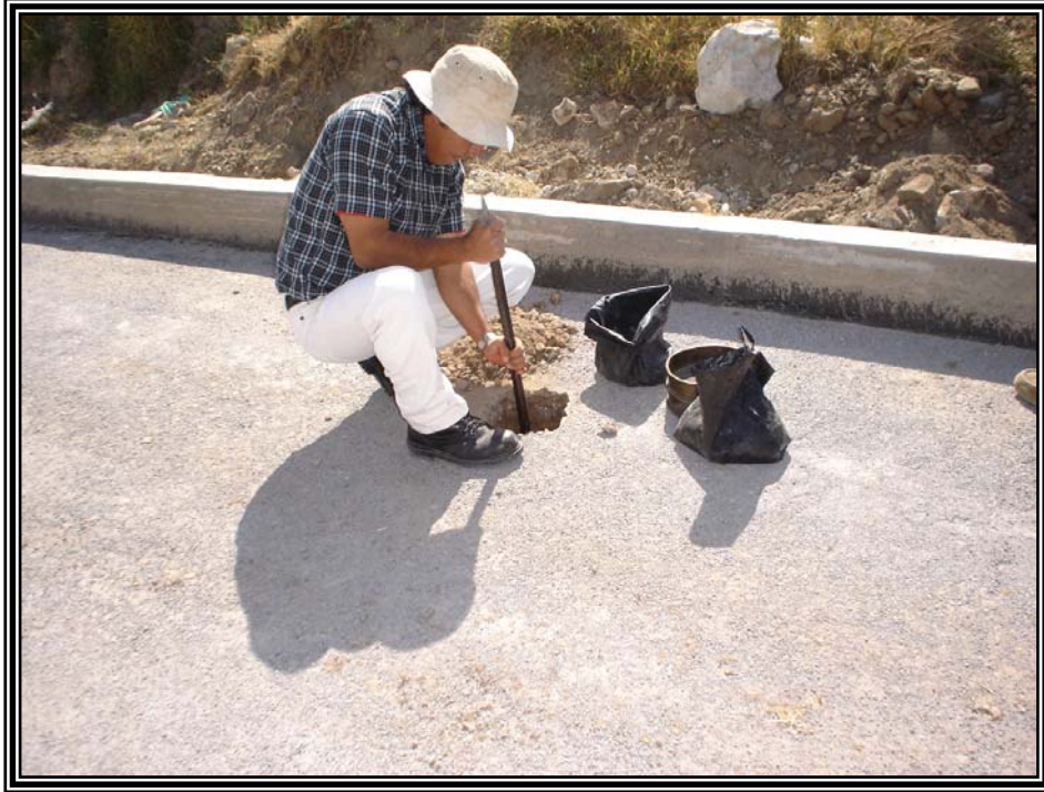
Figura 30. Obtención del grado de compactación en la capa de base hidráulica
