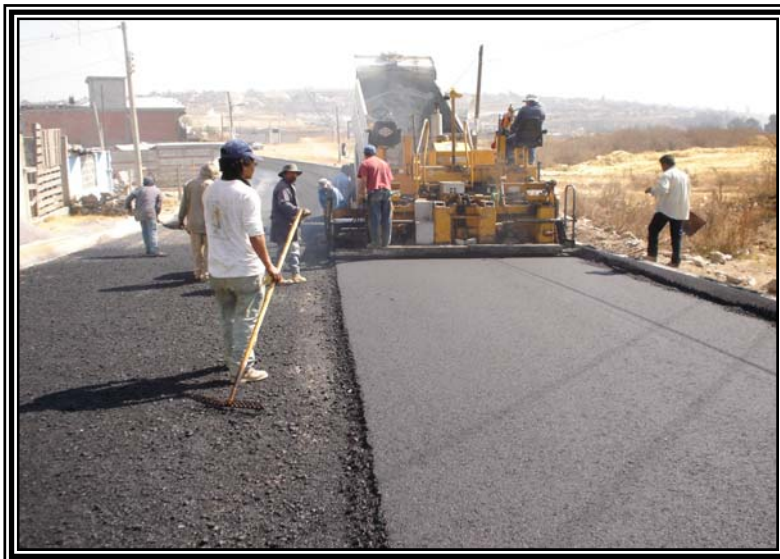
Figura 28. Tendido de carpeta asfáltica.
