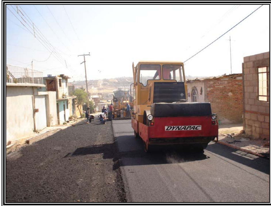
Figura 29. Compactación Carpeta asfáltica mediante un rodillo tandem.
