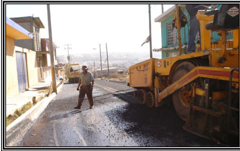
Figura 27. Riego de liga previo al tendido de la carpeta asfáltica.
