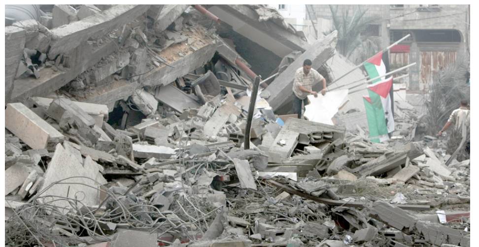
Un miembro de seguridad inspecciona el edificio de oficinas destruidas de primer ministro de Hamas Ismail Haniya este sábado. (Foto Diario Co Latino/AFP/Mahmud Jamones)
