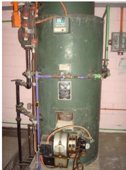
Figura 13. Caldera Piro tubular utilizada para realizar la concentración.
