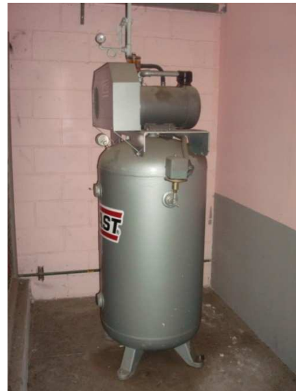
Figura 8. Bomba que produce el vacío en el equipo de filtración (derecha).
