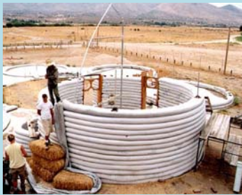
Foto No. 1. 9. Levantado de muros con superadobe.
