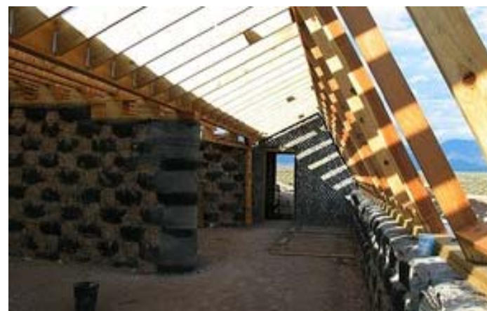
Foto No. 1. 17. Vivienda construida con llantas. Fuente: Portal Web Earthship.
