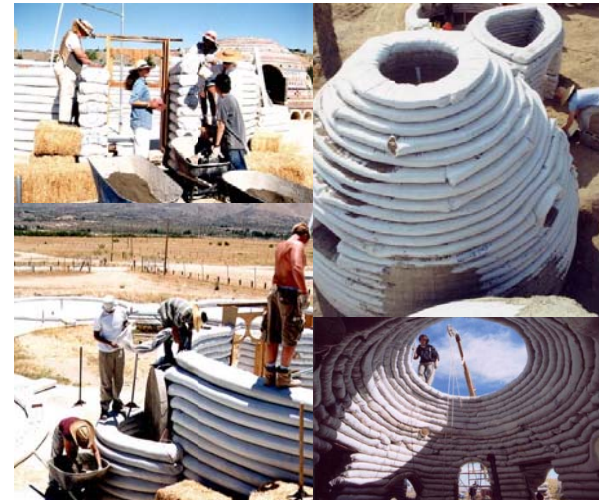
Foto No. 4.2. Los materiales que se utilizan son sacos o costales de 100 y 50 kgms, tierra, alambre de púas, arena, cemento y madera.
