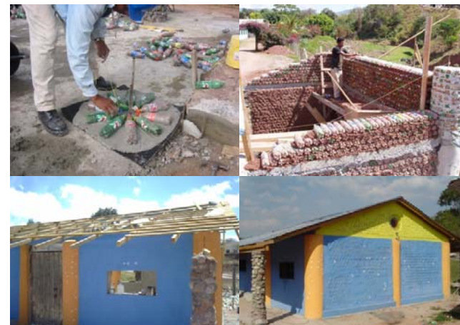
Foto No. 4.3. Aquí se utilizan botellas PET, tierra, cemento, madera, hierro, pita plástica y piedra. Fuente: Web oficial sistema ECOTEC.
