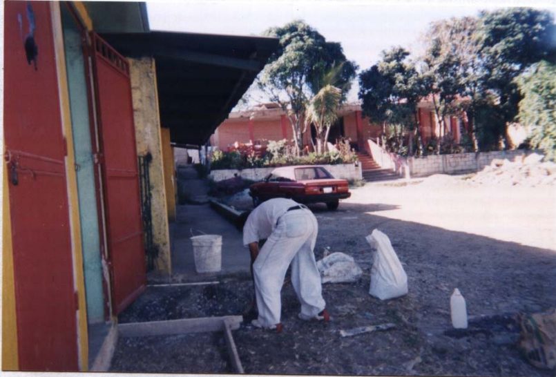
Este es la construcción de los servicios sanitarios en su proceso de construcción.
