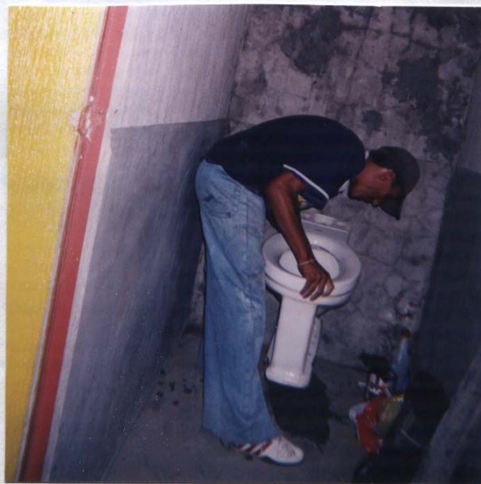
Este es momento cuando uno de los albañiles esta colocando las tazas sanitarias en los sanitarios para jornada nocturna del Instituto Básico Nocturno INBACCOOP.
