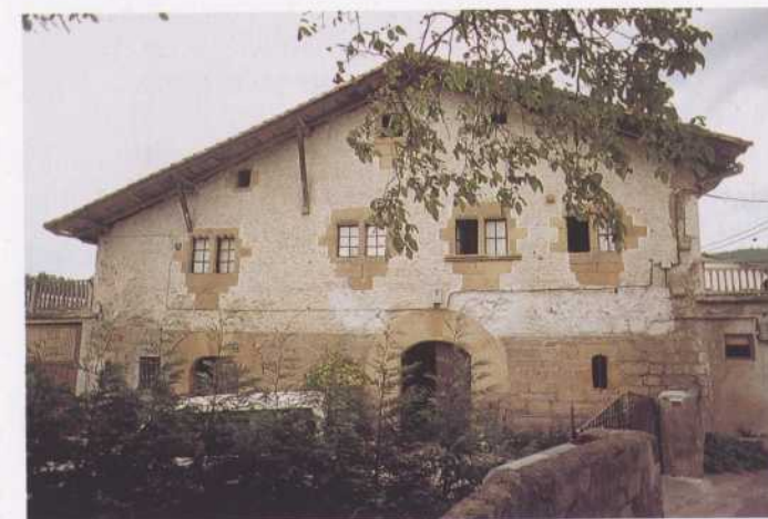
115. Makutsok (Oiartzun) landajauregi errenazentista dirudi, baina bere barneko espazioen antolaketa edozein lurgintzarako etxerena bezalakoa da. Sarrerako bi ateek pertsonen eta abereen sarbidea bereizten dute.
