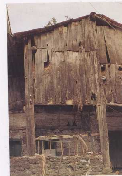
123. Tomas de Zumalacarregui jeneral karlistaren jaiotetxea, Iriarte izenekoa (Ormaiztegi), haritzeko enbor eta oholekin eraikita dago.
