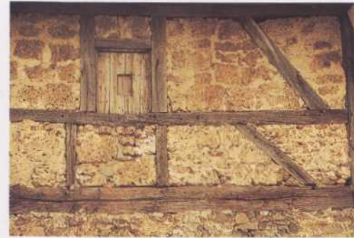
117. Tuharri porotsuz betetako bilbadura baten zatia, Altzo Muñon.
