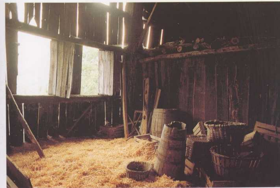
94. Igartubeiti baserriko (Ezkio-Itsaso) ganbara. Gipuzkoako baserriaren goiko solairu osoa uzta gordailatzeko erabiltzen zen eta ondo aireztatuturik egon behar zuen jasotako fruituak ez hondatzearren.
