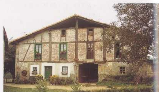
76. Iriarte baserria (Altzo). Adreiluz betetako bilbadurarekin egindako fatxadak ohizko bihurtu ziren XVII. mendearen bukaeran.
