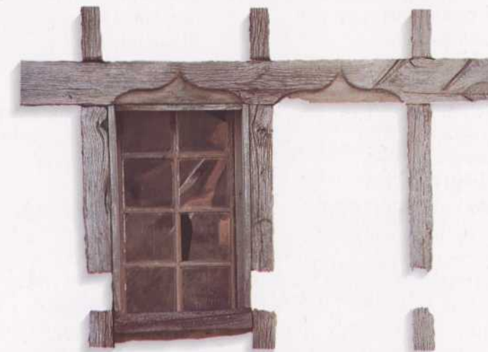
137. Kargaderoan arku konopialak tailatuta dituzten leihoen galeria, Aritzeta Erdin (Alkiza), XVI. mendea.
