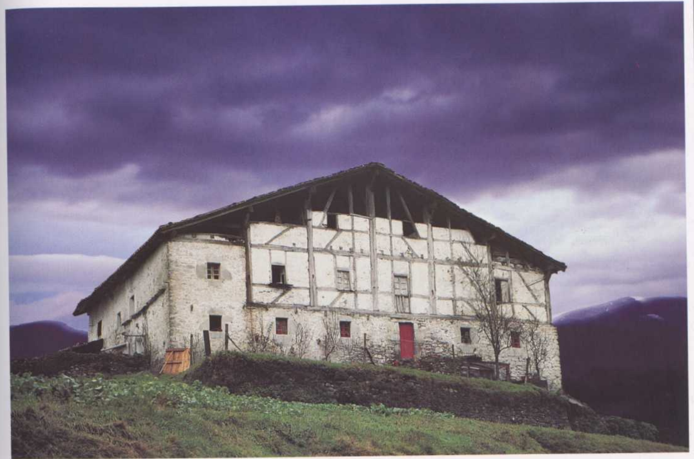
118. Bilbadura-egiturak merkeak eta arinak ziren, eta baserri handiak prezio onean eraikitzea ahalbidetzen zuten, adibidez Etxehaundi (Lizartza).
