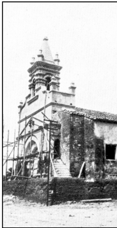
Iglesia de Parita en reconstrucción.
