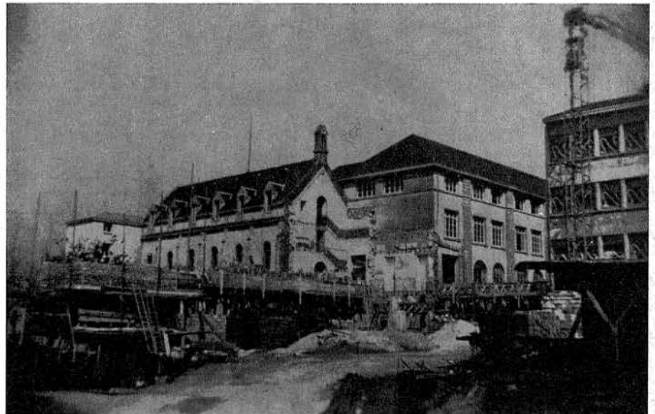
La troisième tranche de nos constructions (bâtiment de direction et d'administration) en avril, un an après l'ouverture du chantier.
