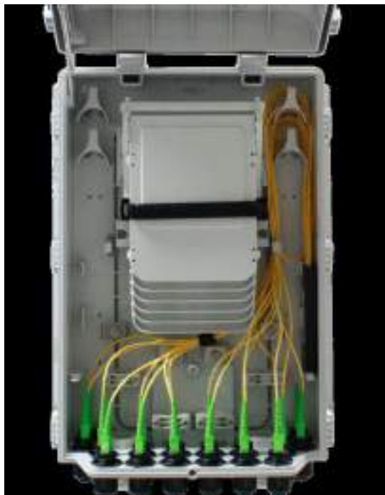
Imagen 3.12. Detalle exterior abierta de CTO Exterior
