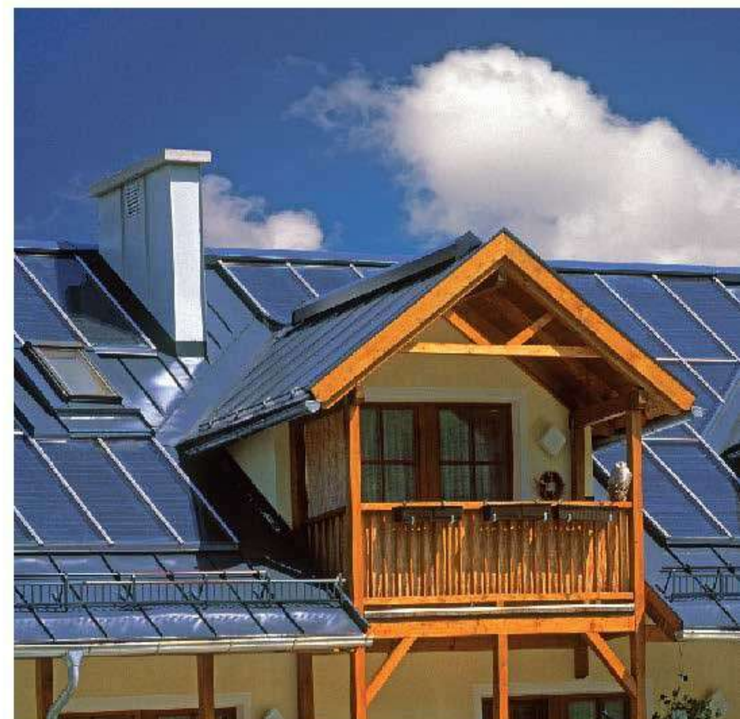
◆ Paneles solares en Viena, Austria.
