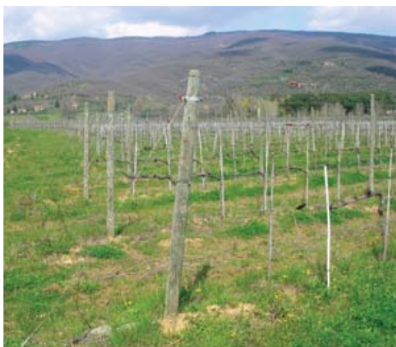
14. Se posizionato in verticale il palo ben presto viene "tirato" verso l'interno del vigneto (anche perché il tirante, non sufficientemente teso, è ancorato troppo lontano e i tendifilo sono troppo vicini alla testata)
