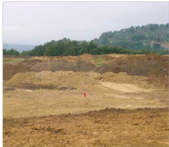
13. Opere di sbancamento per l'impianto di vigneti
